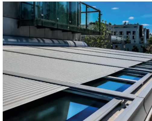
Relevé réalisé sous contrôle d'huissier
